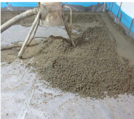
Abbildung A 2.3: Montagesituation Zementestrich
